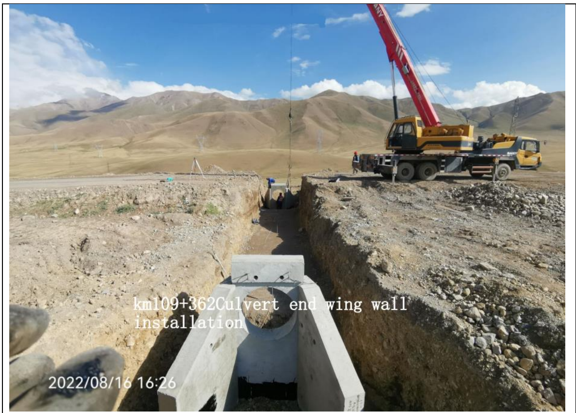
Рисунок 3 Дорожные работы на проекте
