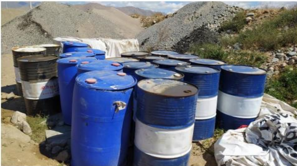
Фото 7: На производственной базе бочки из под масла не прикрыты и низ не забетонирован
