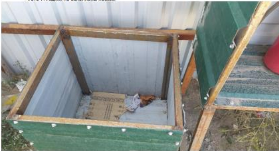
Photo 7: The boxes are not filled with sand Фото 7: Ящики не заполнены песком
